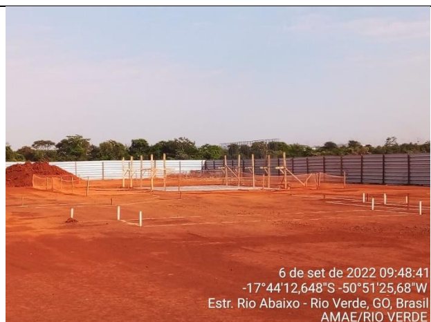
Autor: AMAE/RIO VERDE Descrição: Estrutura para tanque de contato, na ETE Laje.
